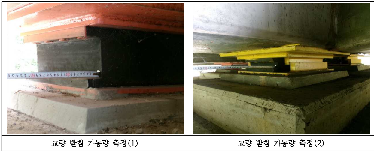
【사진 2.3.40】 교량받침 이동량 측정
