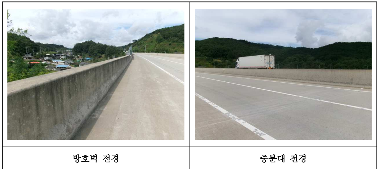
【사진 2.3.48】 방호벽 및 중앙분리대 전경
