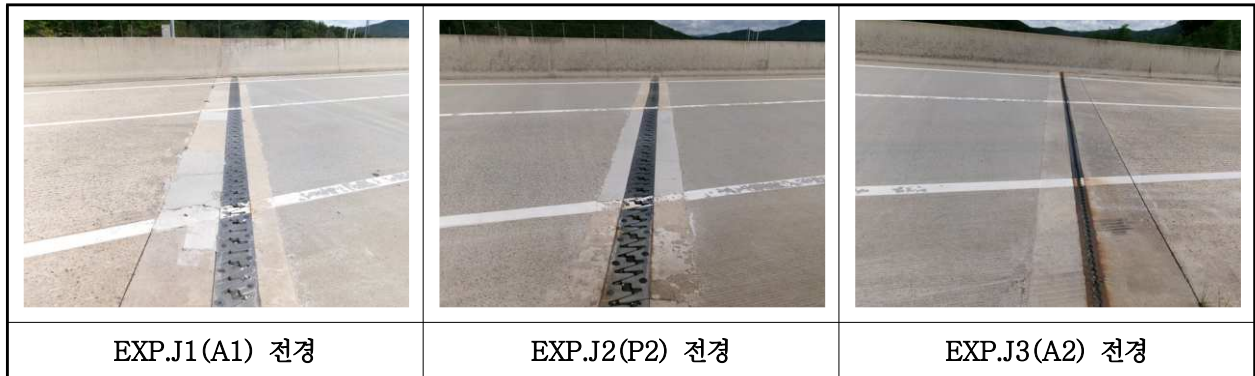
【사진 2.3.41】 신축이음장치 전경
