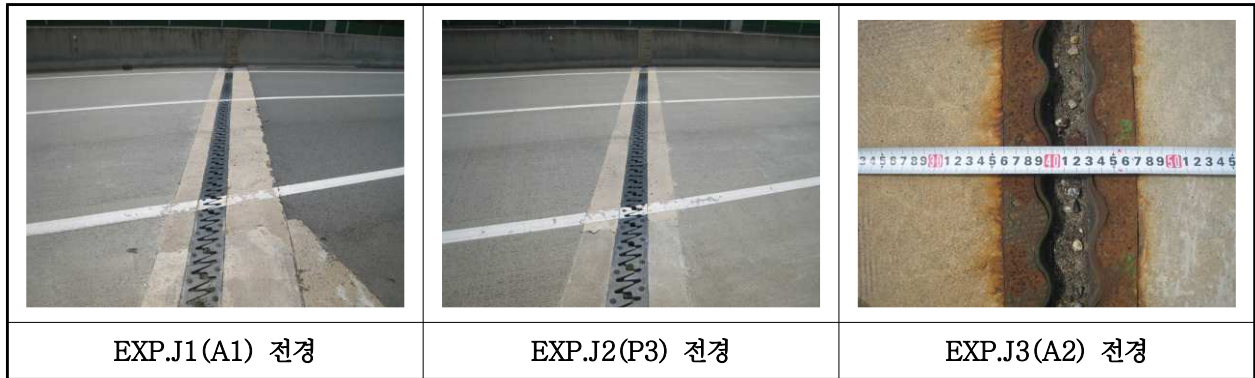
【사진 2.3.16】 신축이음장치 전경
