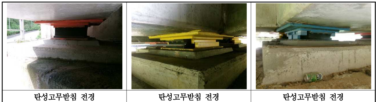
【사진 2.3.37】 교량받침 전경
