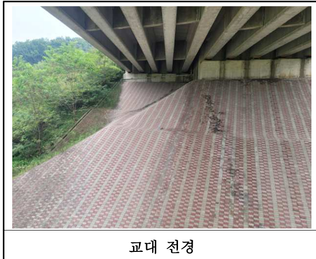
교대 전경 【사진 2.3.8】 교대 전경
