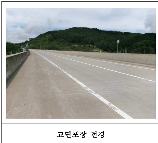
【사진 2.3.44】 교면포장 전경
