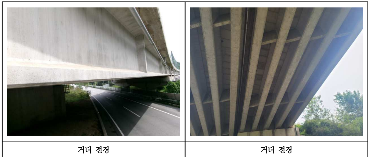
【사진 2.3.29】 거더 전경
