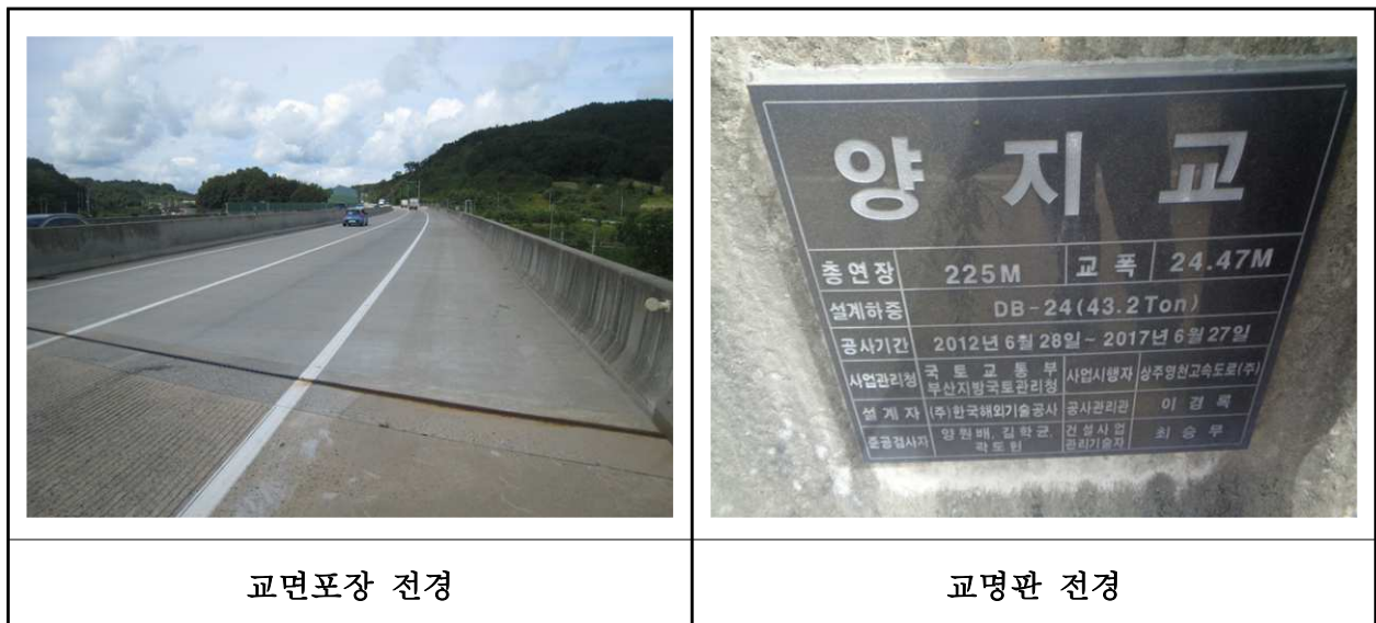
【사진 2.3.19】 교면포장 전경
