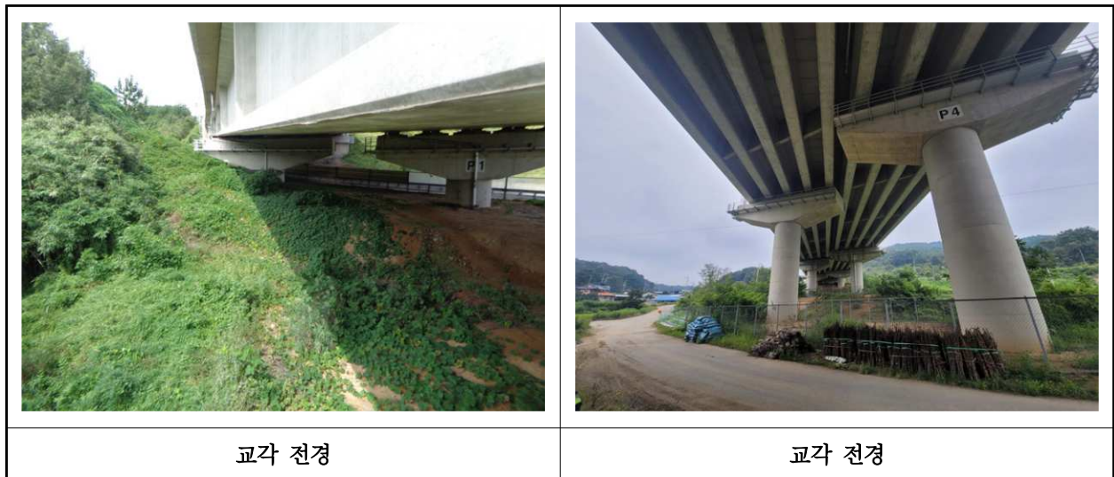
【사진 2.3.35】 교각 전경
