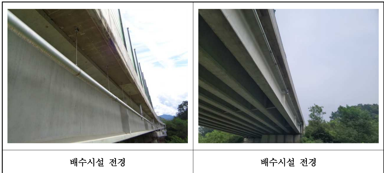
【사진 2.3.46】 배수시설 전경
