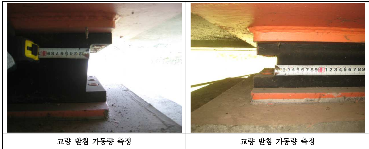
【사진 2.3.15】교량받침 이동량 측정
